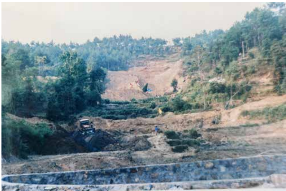
正在建设中的赵朴初树葬地
