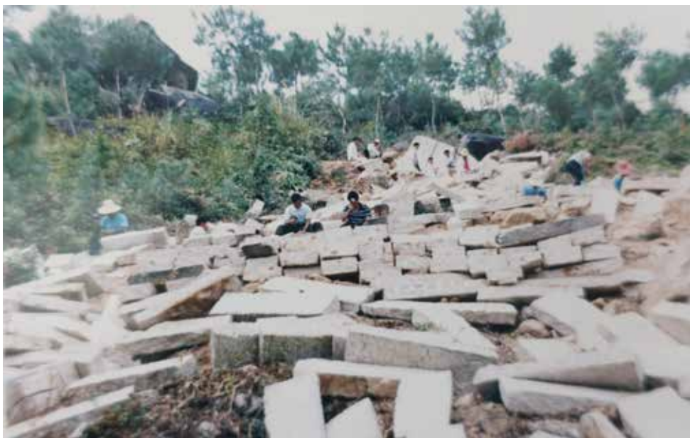
工人们正在紧张打制石条
